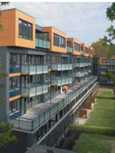
De gestapelde bebouwing uit de jaren zestig in de Vlaardingse wijk Holy-Zuidoost is door A3 Architecten ingrijpend gerenoveerd.
