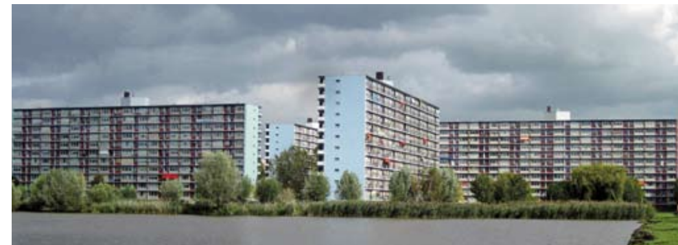
Na-isolatie Prinsesseflats, Rotterdam. Dit is wat er gebeurt als er geen architect bij betrokken wordt: over het gevelbeeld is niet nagedacht. Het bonte kleurenschema is bedacht door de projectleider van de aannemer.
